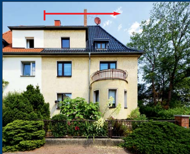
Mehrfamilienhaus in Halle, Pos. 18
